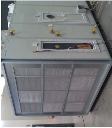
净化装置安装在空调机组后检测
